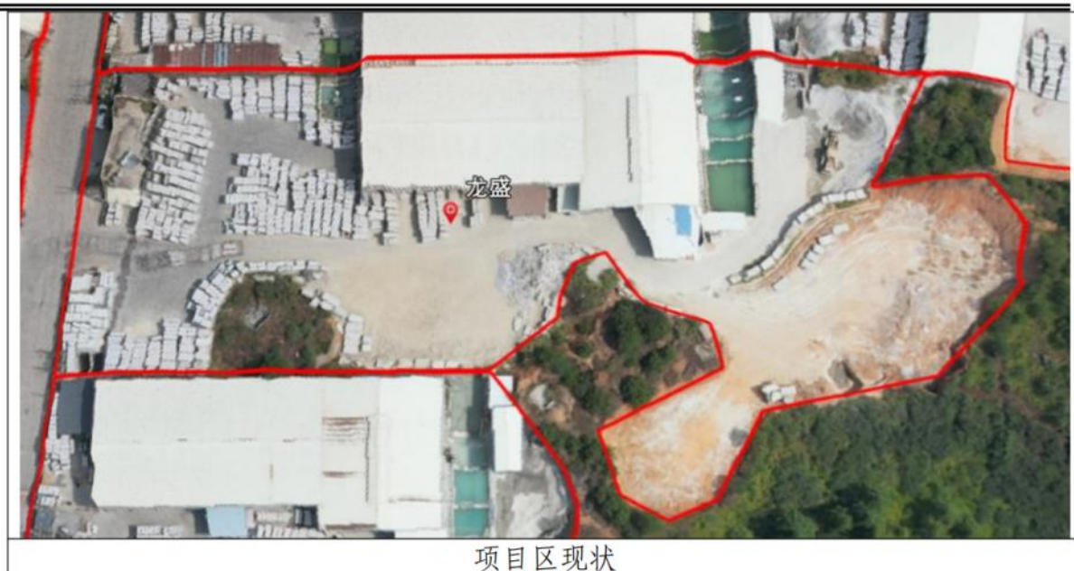
图 1-1 项目区现场航拍图片
