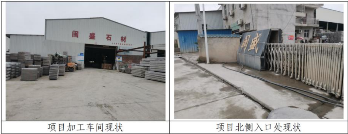
图 1-1 项目区现场照片
