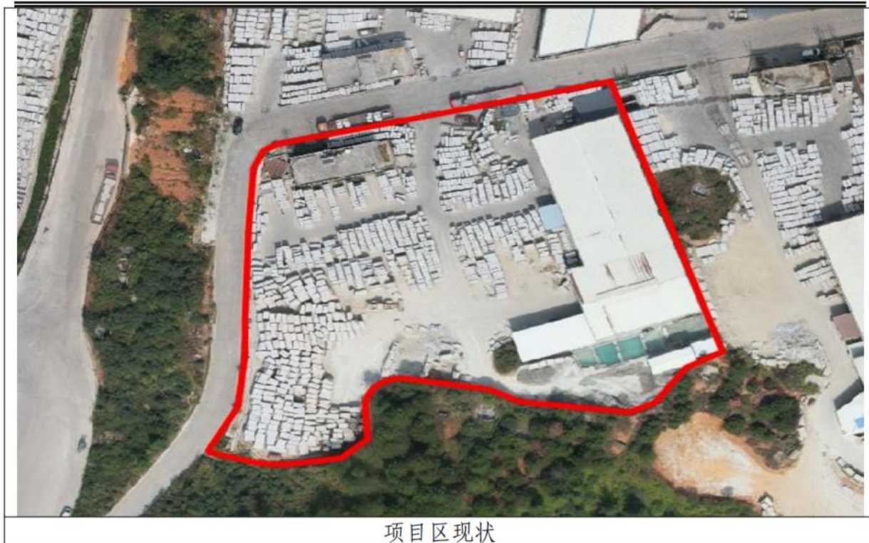
图 1-1 项目区现场照片
