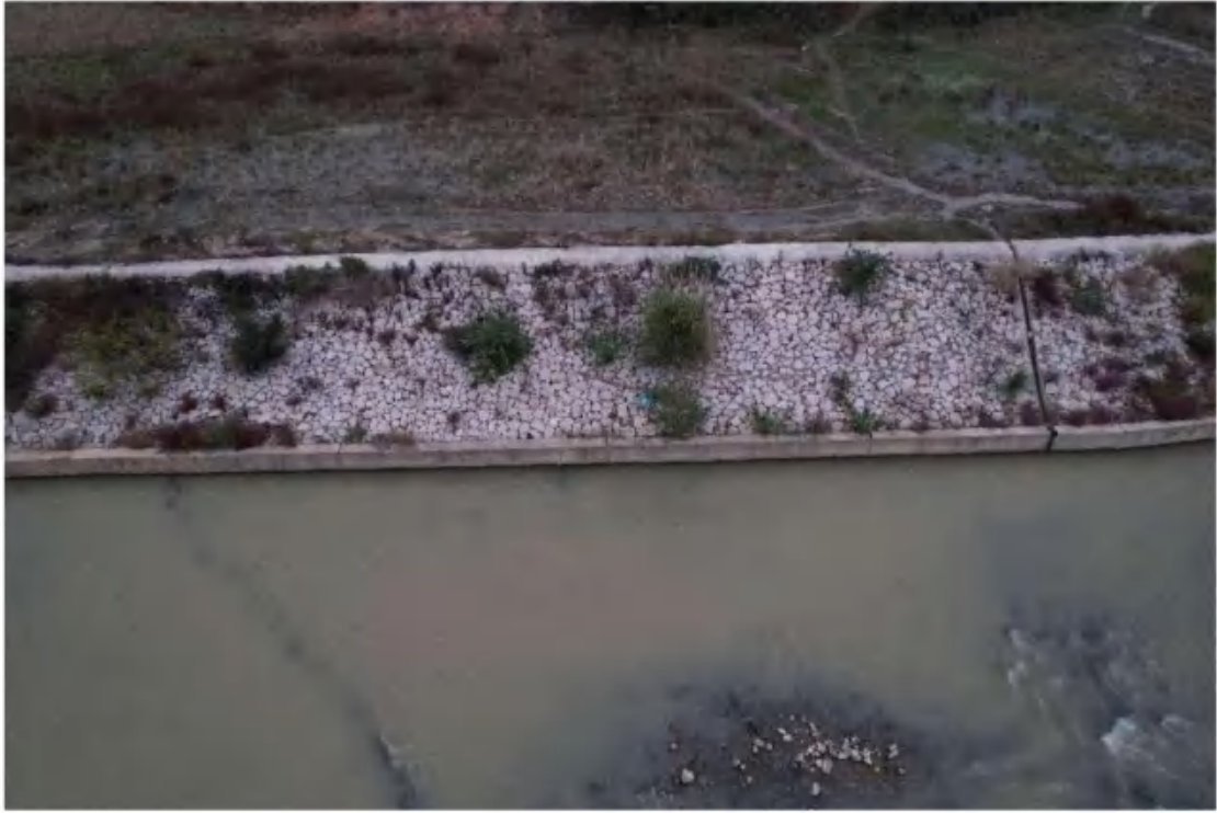
主体工程防治区干砌石护岸（2022年11月）
