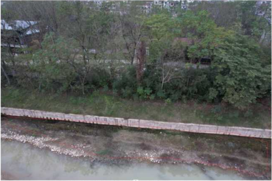
施工临时场地防治区撒播草籽（2022年11月）
