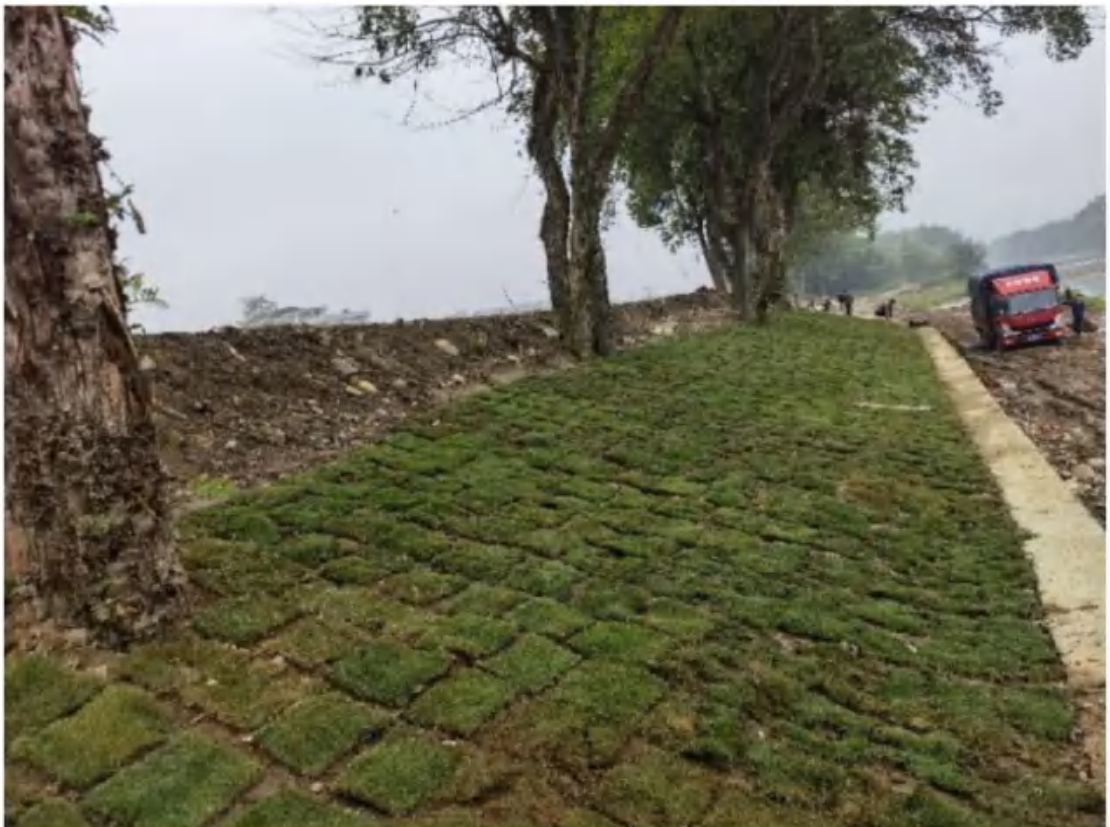
主体工程防治区草皮护坡（2022年11月）
