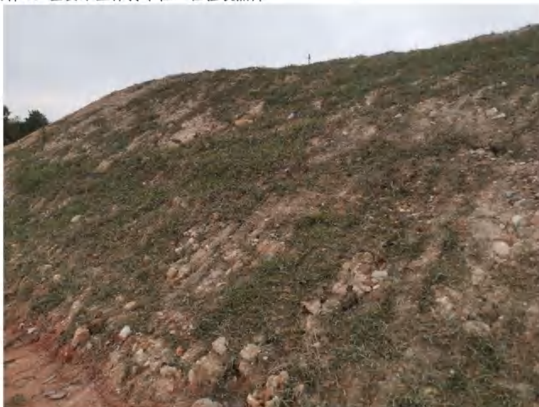
取土场防治区撒播草籽（2022年11月）
