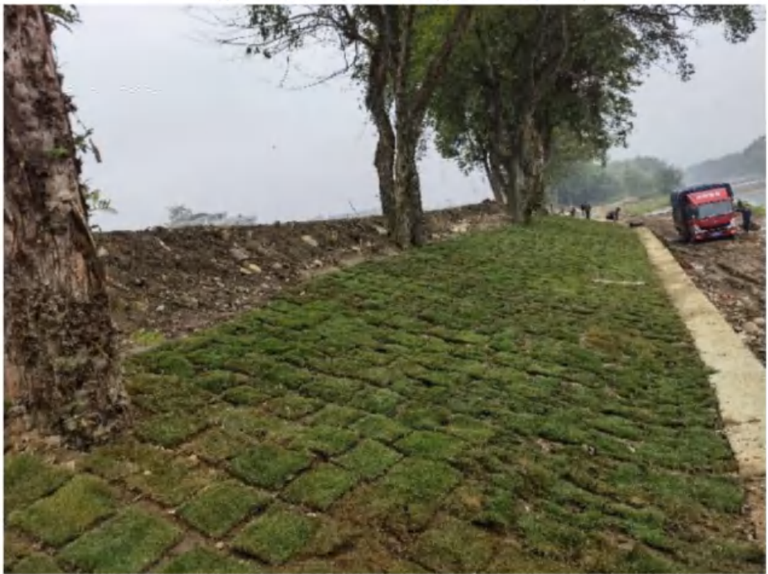
主体工程防治区草皮护坡（2022年11月）
