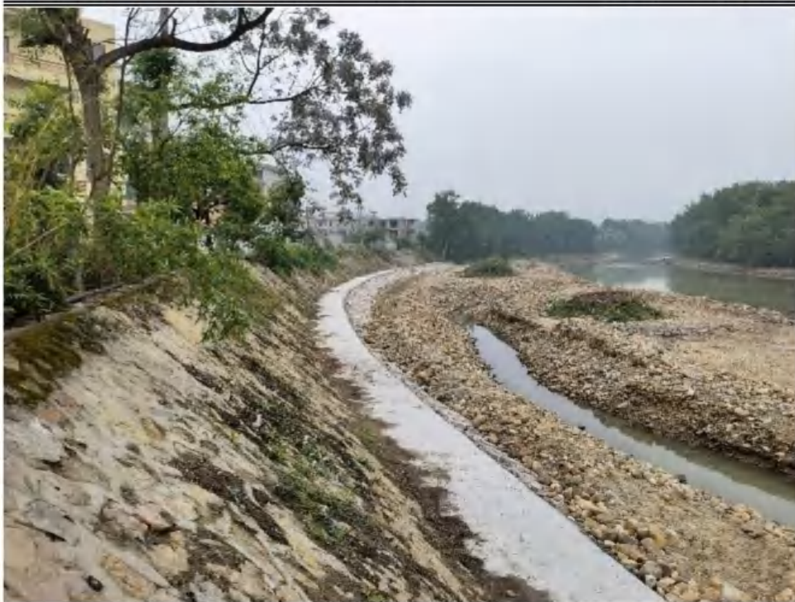
2022年11月现场主体工程防治区干砌石护岸实施情况
