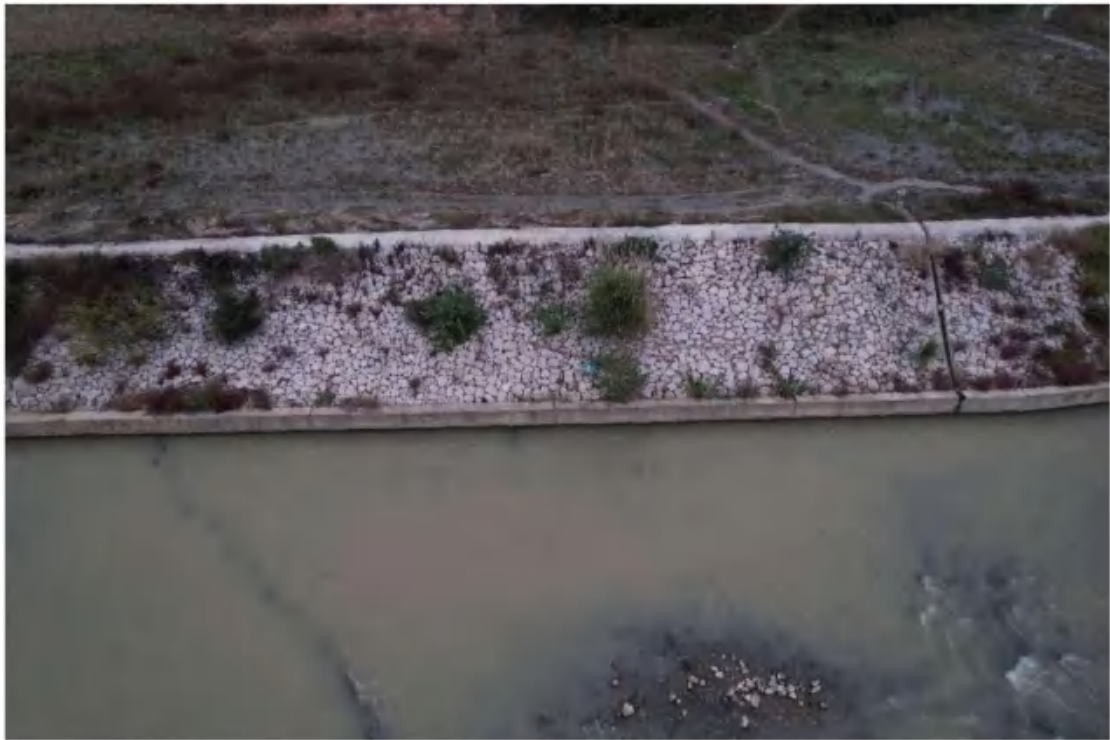
主体工程防治区干砌石护岸（2022年11月）
