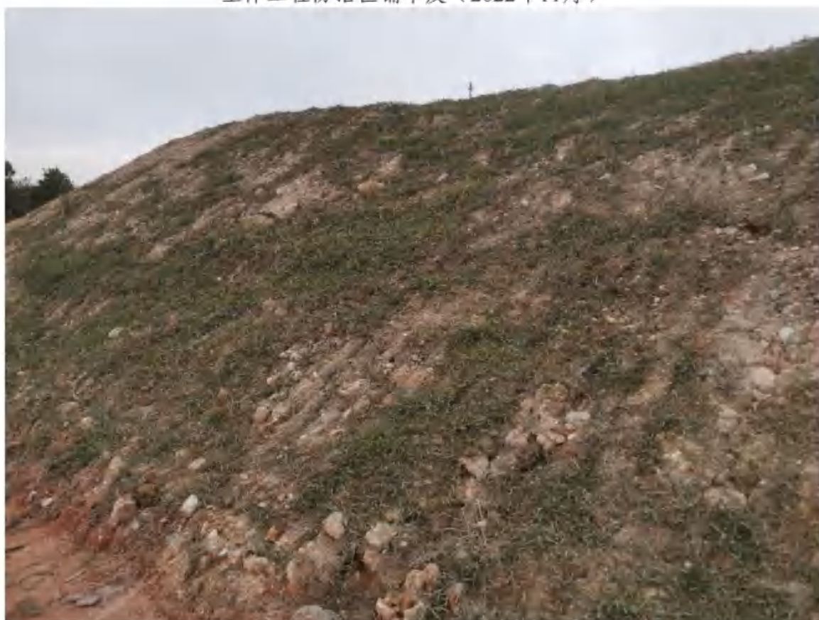
取土场防治区撒播草籽（2022年11月）
