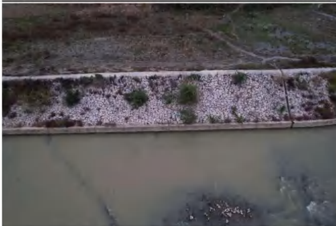
主体工程防治区干砌石护岸（2022年11月）
