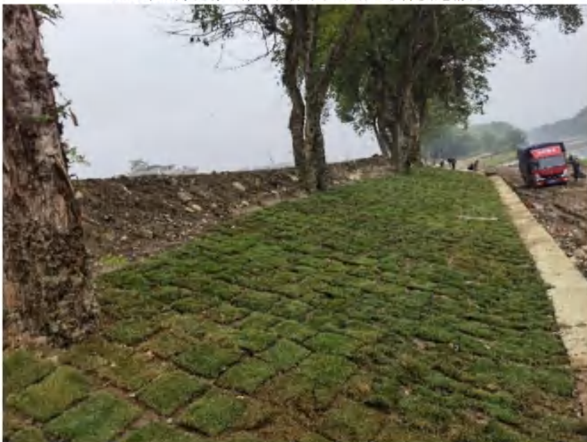
2022年11月现场主体工程防治区草皮护坡实施情况
