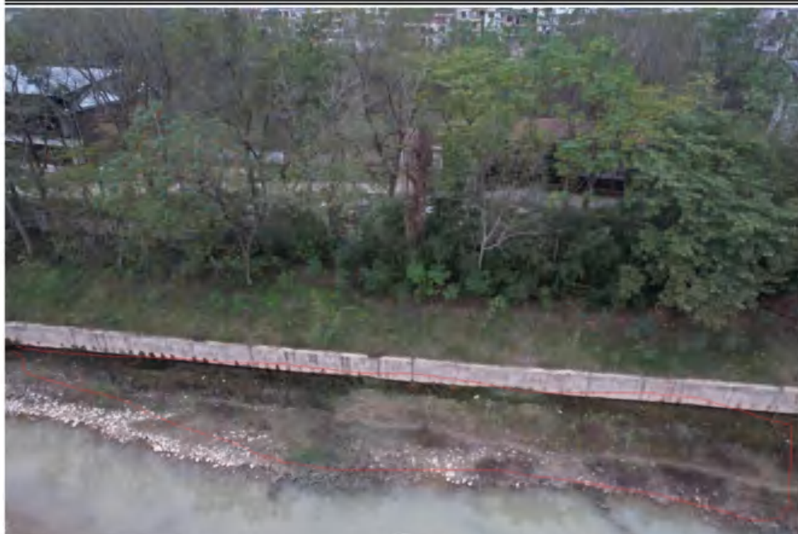
施工临时场地防治区撒播草籽（2022年12月）
