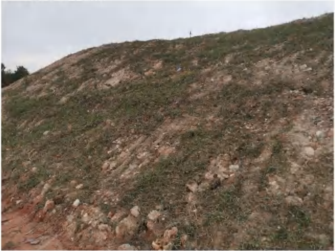
取土场防治区撒播草籽（2022年11月）
