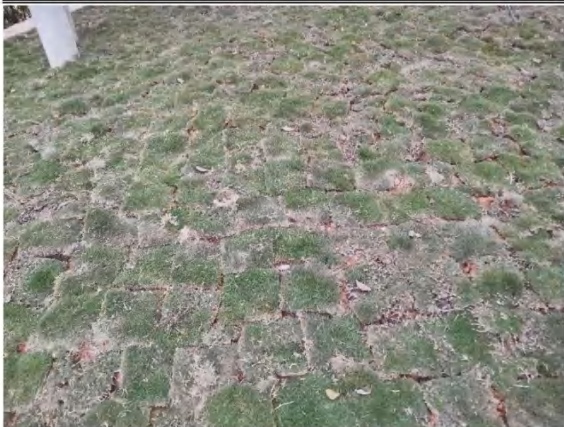
主体工程防治区铺草皮（2022年11月）
