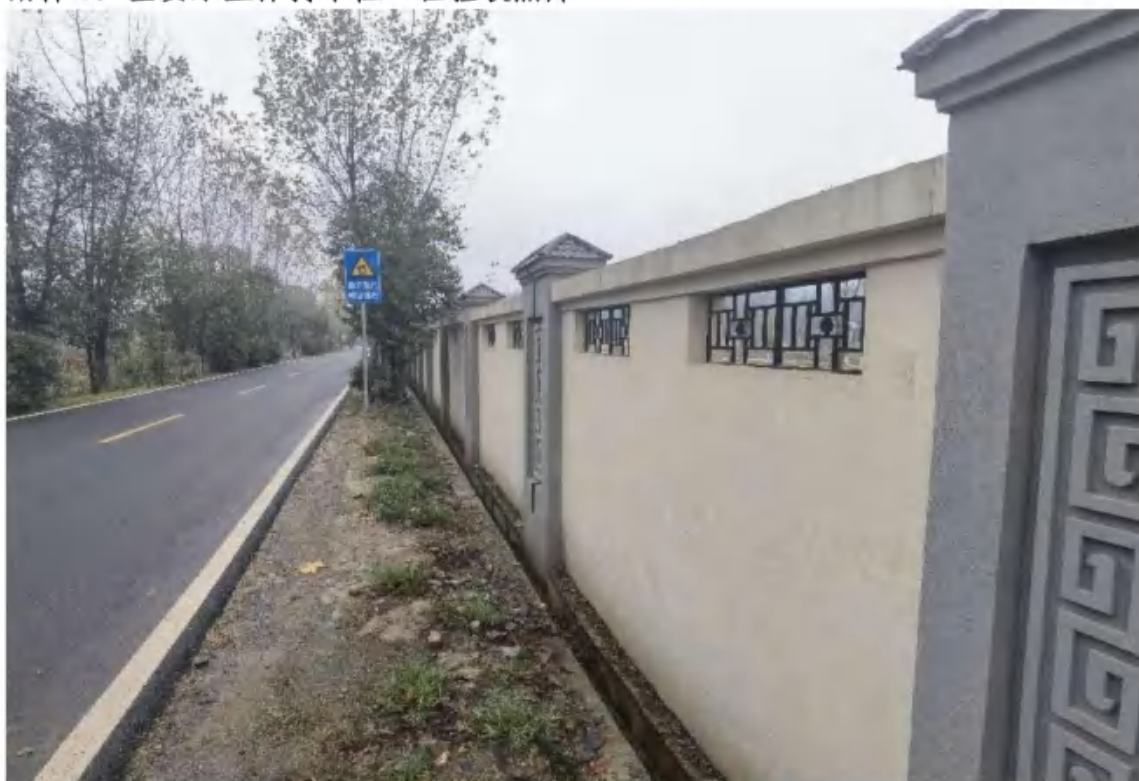
主体工程区排水沟 (2022年11月)
