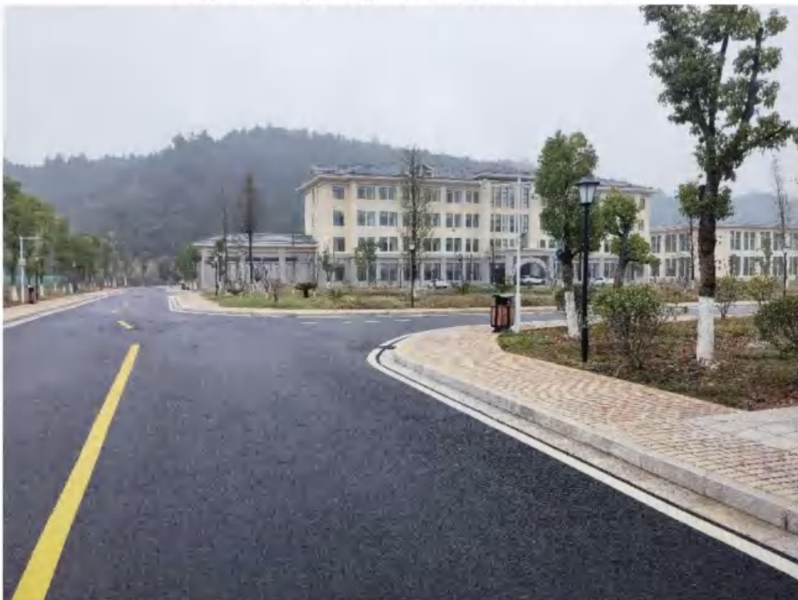
主体工程区雨水口、雨水井（2022年11月）
