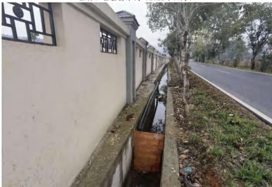
主体工程区排水沟 (2022年11月)
