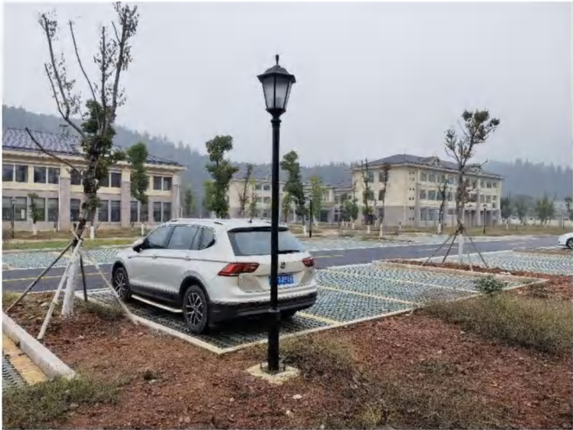
主体工程区透水铺装、园林绿化（2022年11月）
