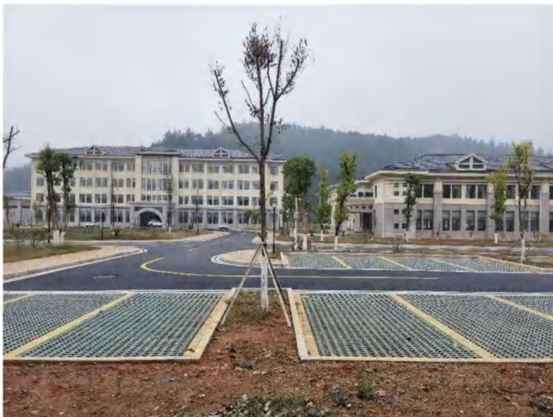
主体工程区透水铺装、园林绿化措施（2022年11月）
