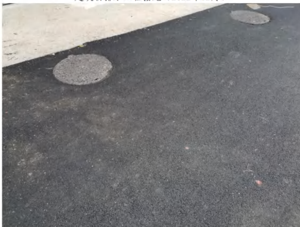
道路广场区雨水井（2022年12月）
