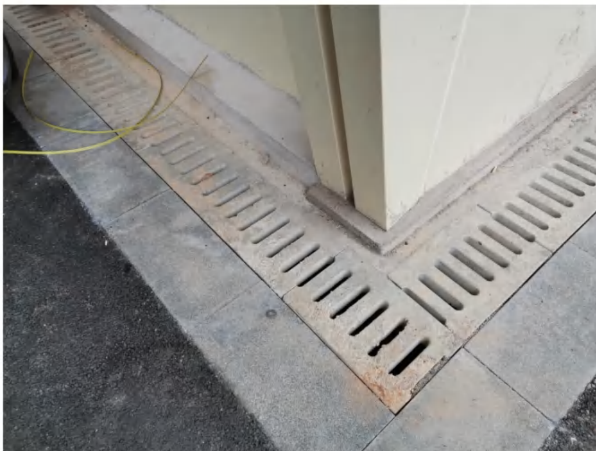
建筑物排水工程措施（2022年12月）
