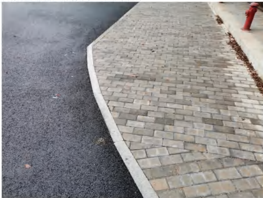
道路广场区降雨蓄渗措施（2022年12月）
