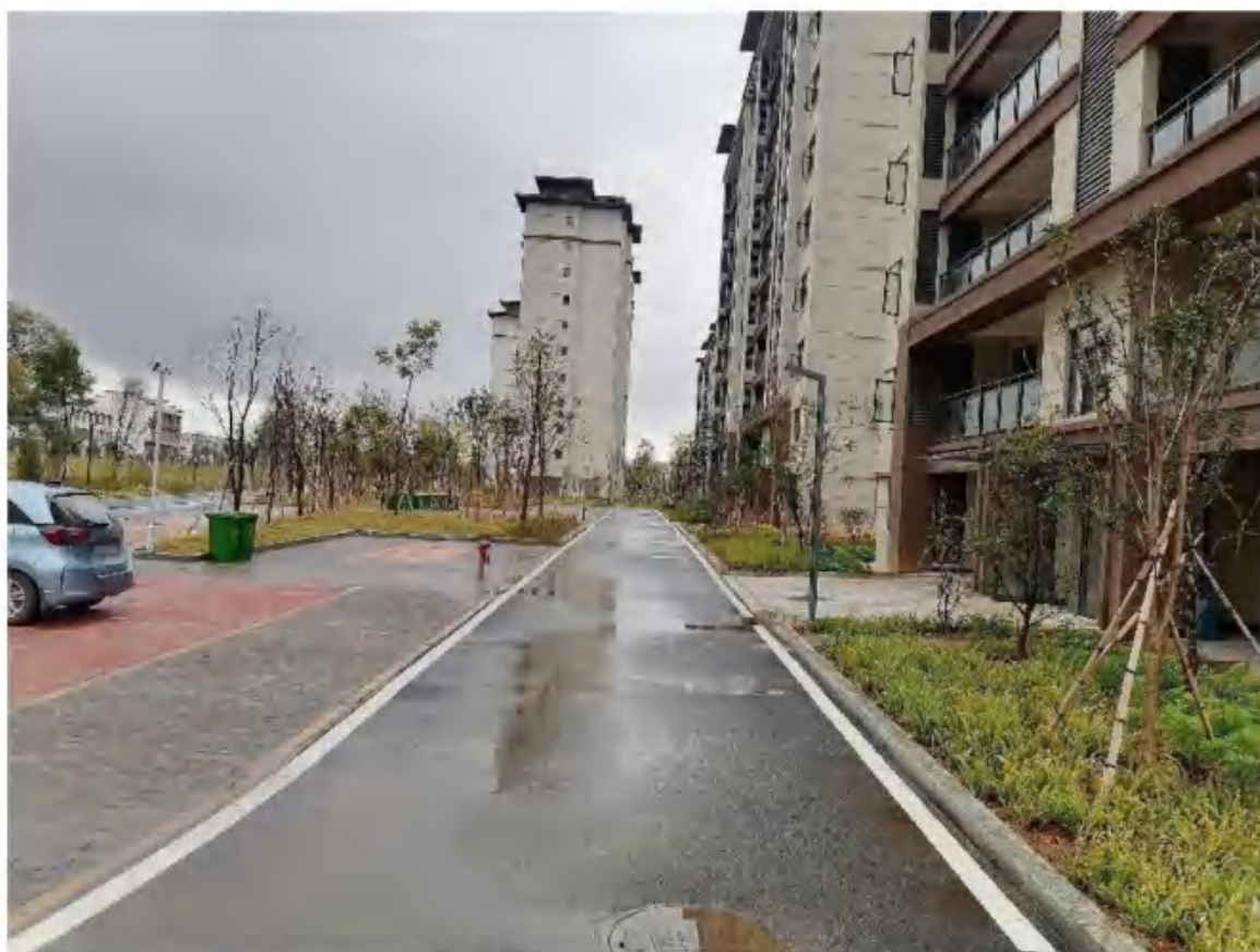
广场道路区透水铺装、景观绿化（2022年11月）
