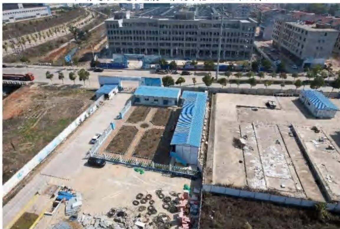
施工临时用地区景观绿化（2022年11月）
