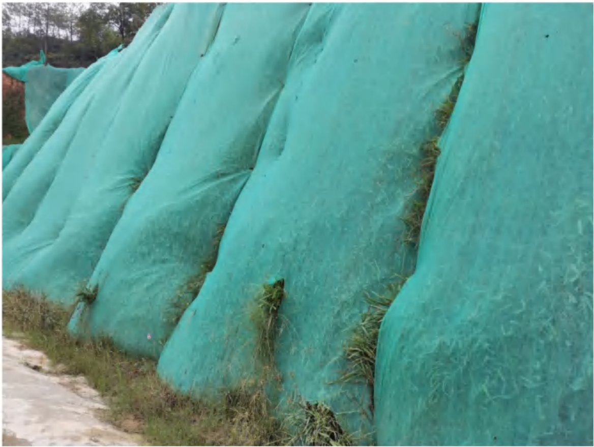
矿山道路区苫布覆盖、种草
