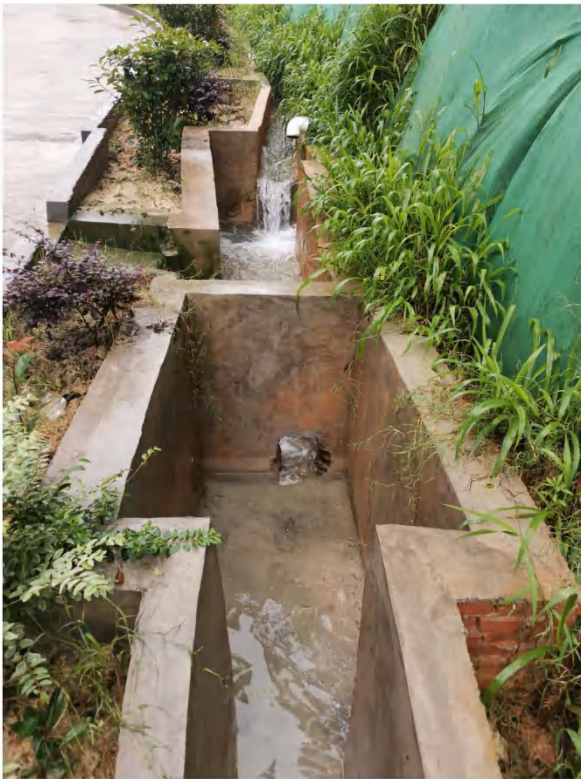
矿山道路区沉砂池
