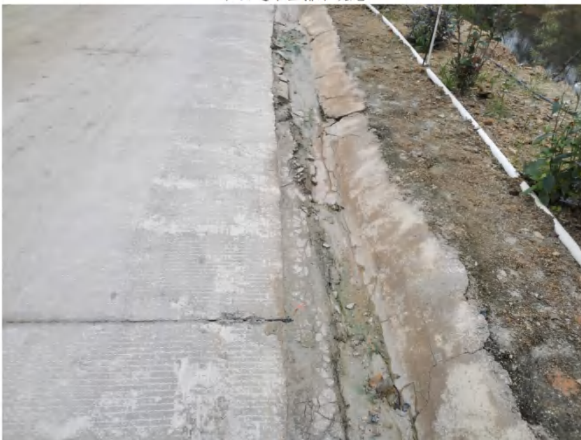
矿山道路区排水设施
