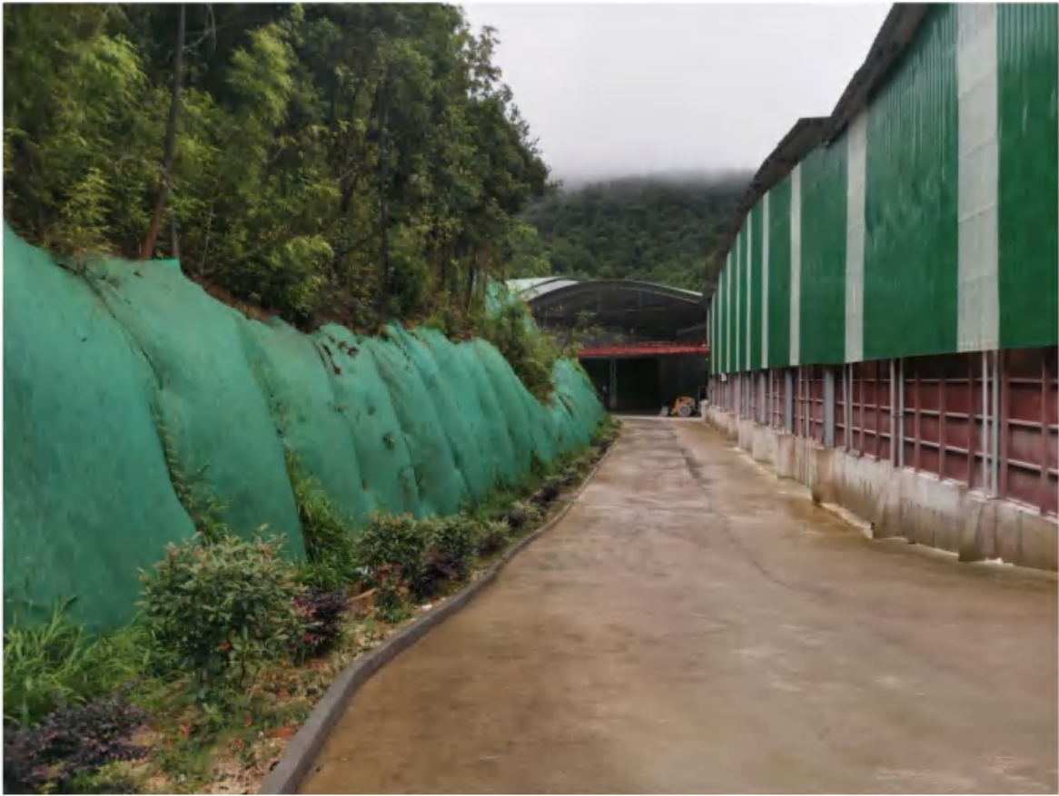
施工生产生活管理区
