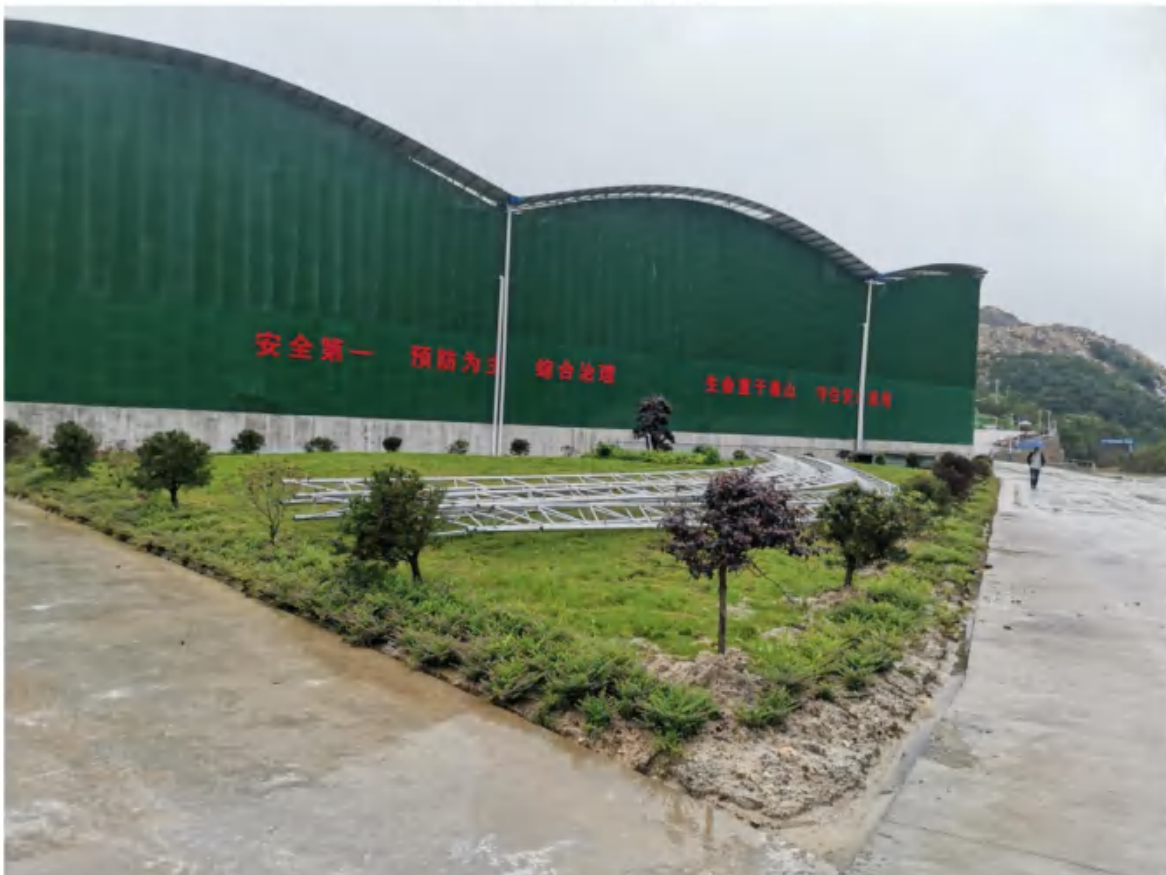
施工生产生活管理区
