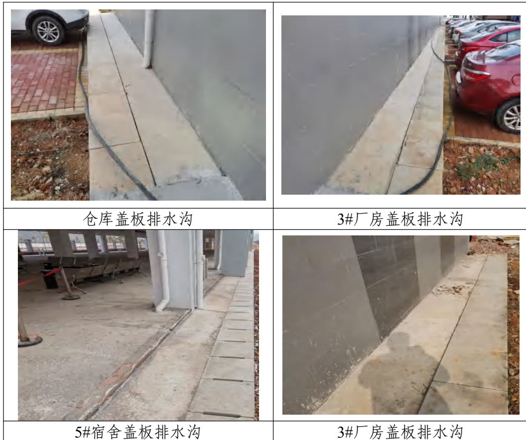
图 2-1 项目区现状情况
