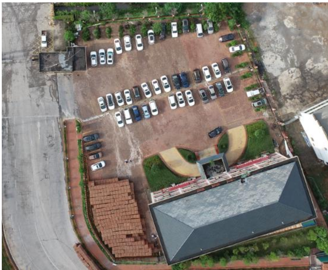
生活办公区绿化工程措施（2021年8月）
