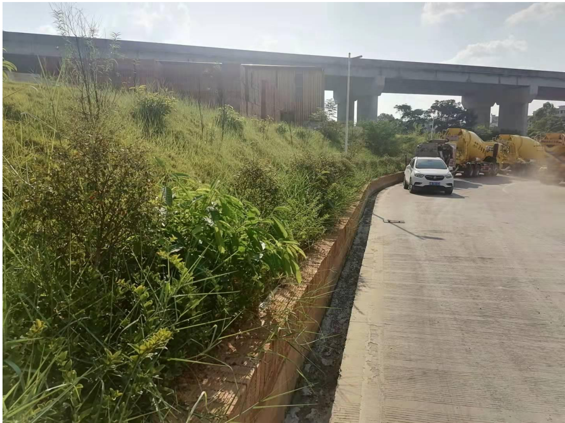
厂区道路区厂区绿化措施（2021年8月）
