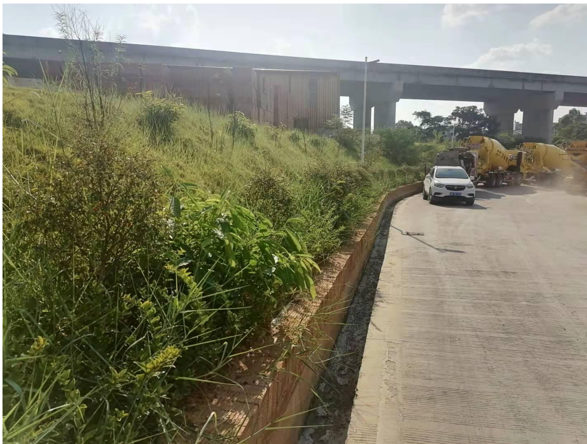
厂区道路区厂区绿化措施（2021年8月）
