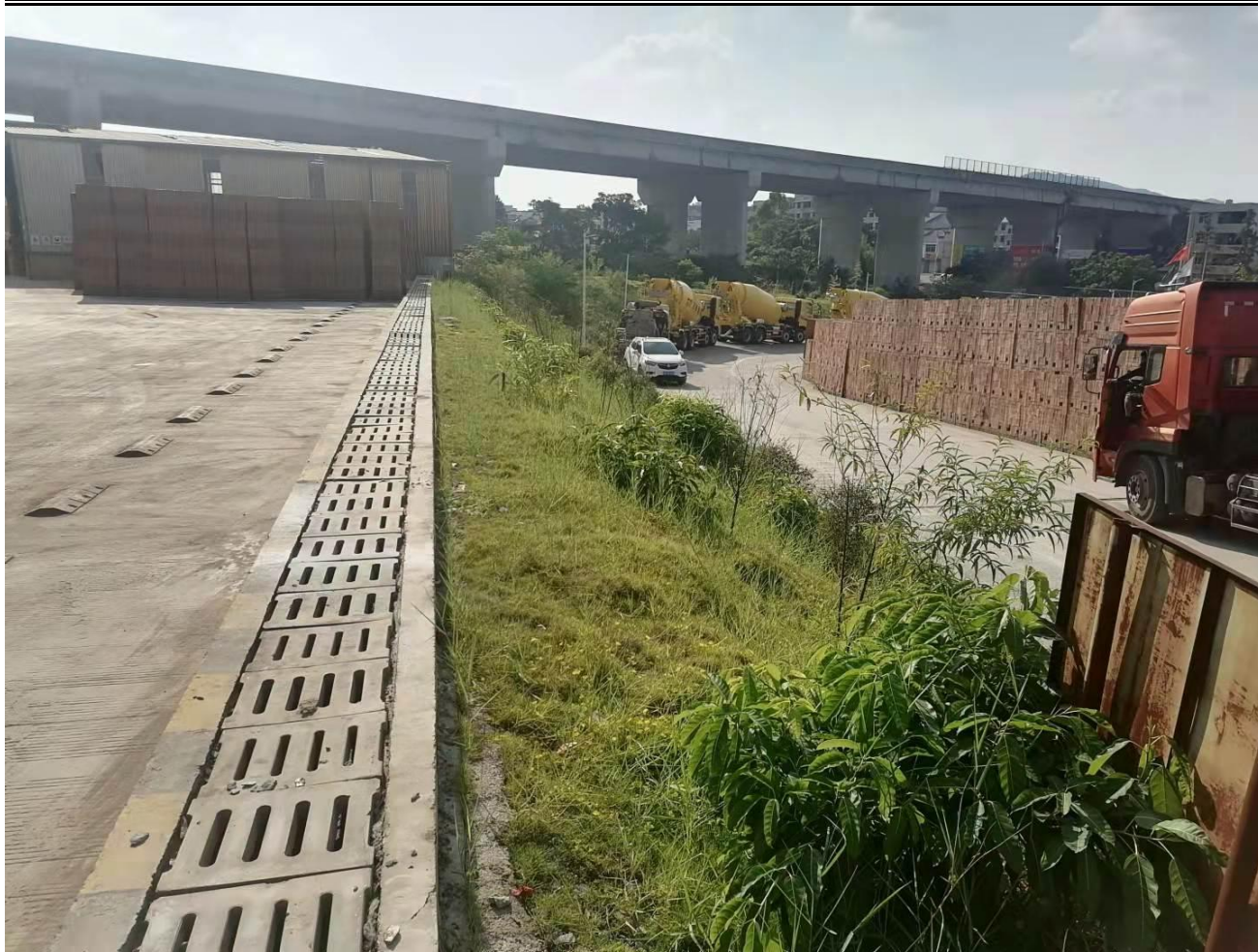
2021年8月现场厂区道路区排水措施实施情况
