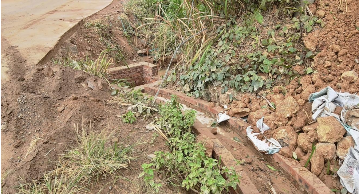
矿山道路区排水沟、沉砂池（2021年9月）
