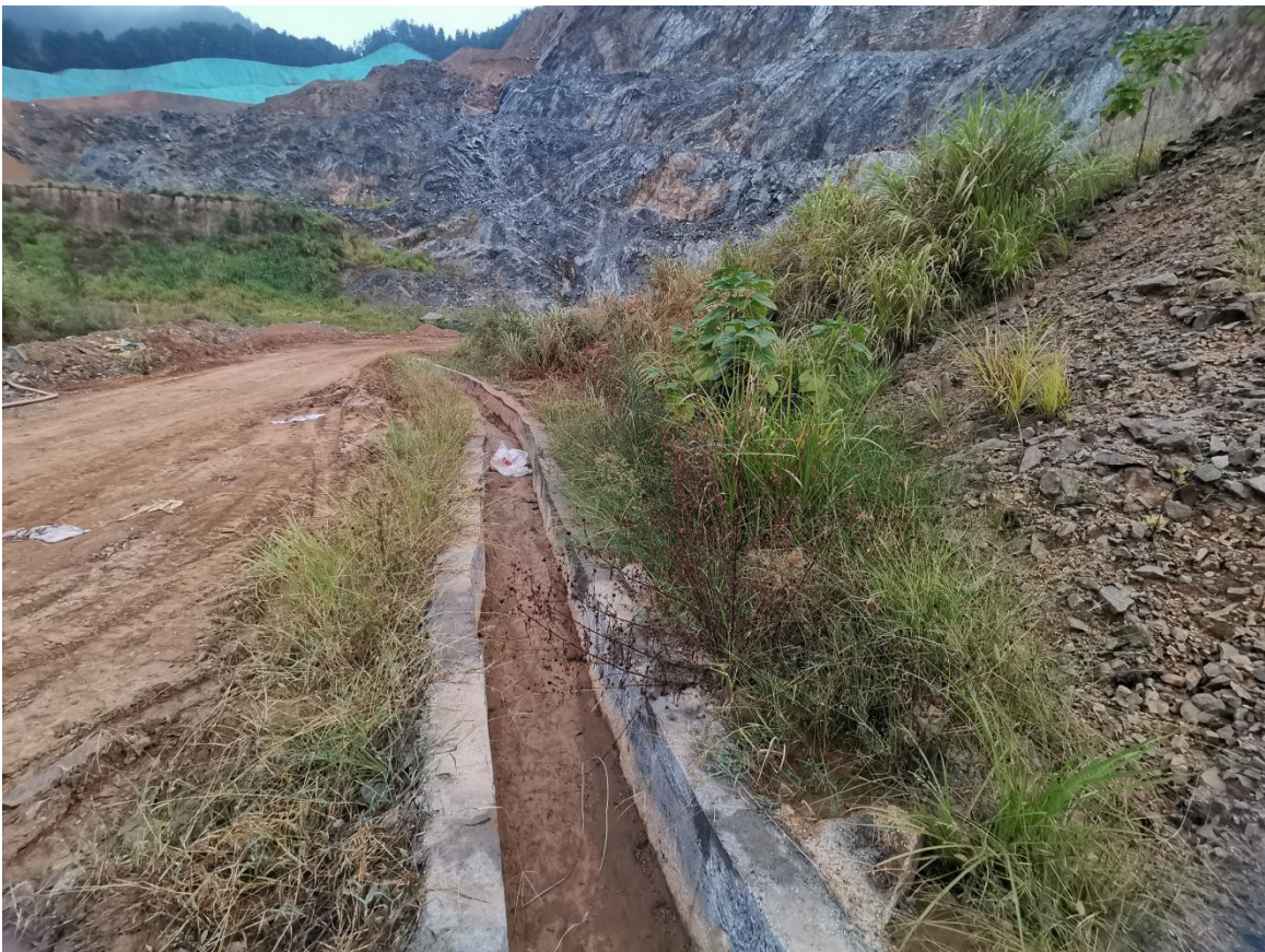
采矿场排水措施（2021年8月）
