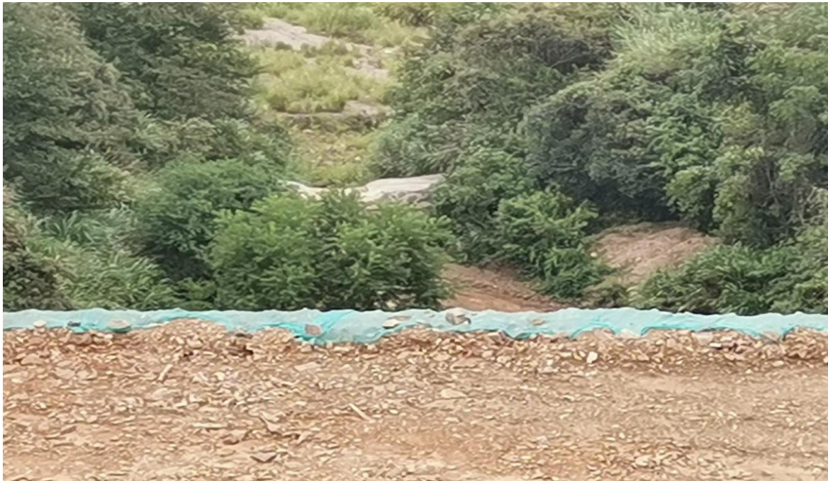
弃渣场浆砌石挡土墙（2021年8月）
