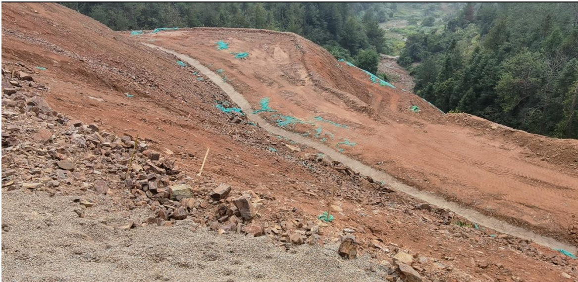
弃渣场排水沟（2021年8月）
