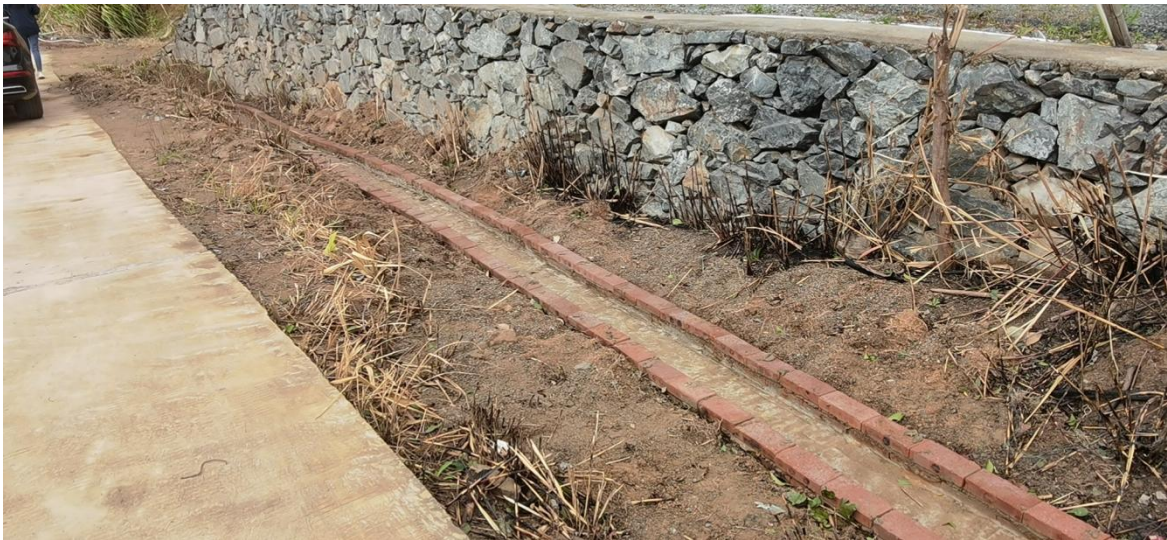
矿区道路排水沟（2021年9月）
