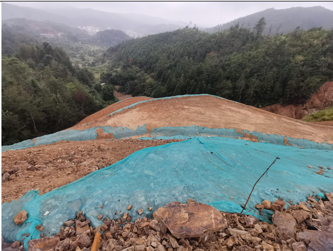
2021年8月现场监测弃渣场区域苫布覆盖、排水沟
