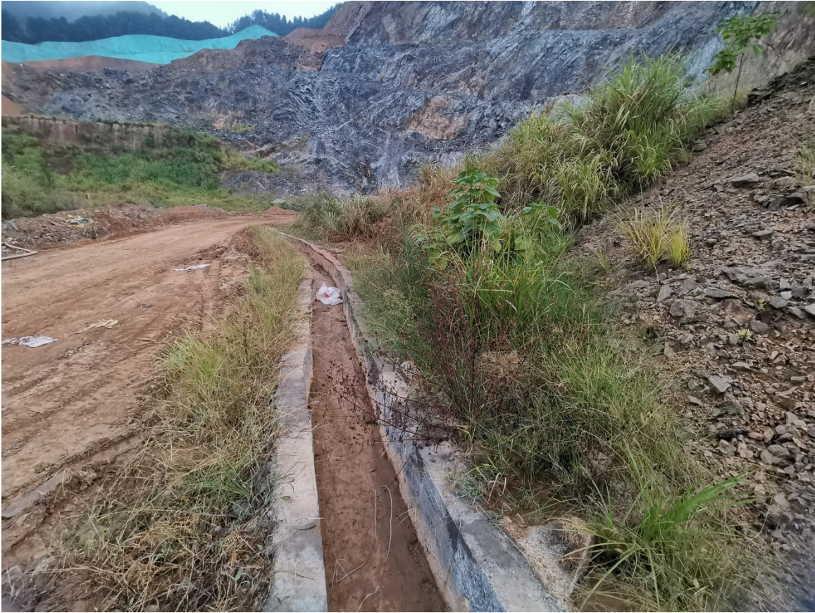
采矿场排水措施、种草 (2021年9月)
