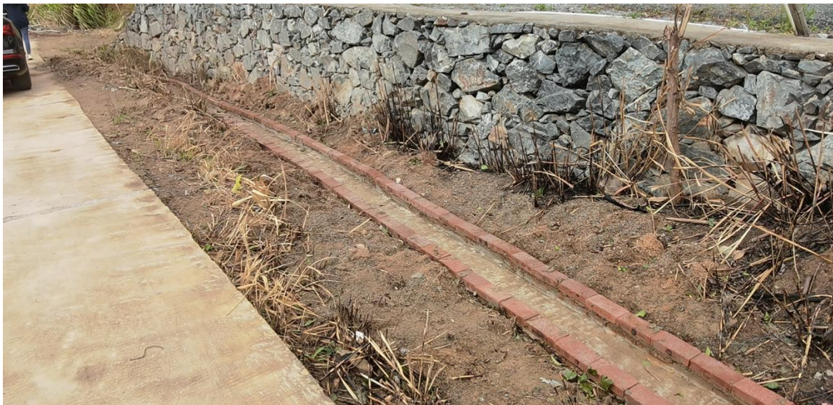
矿山道路区排水设施（2021年9月）
