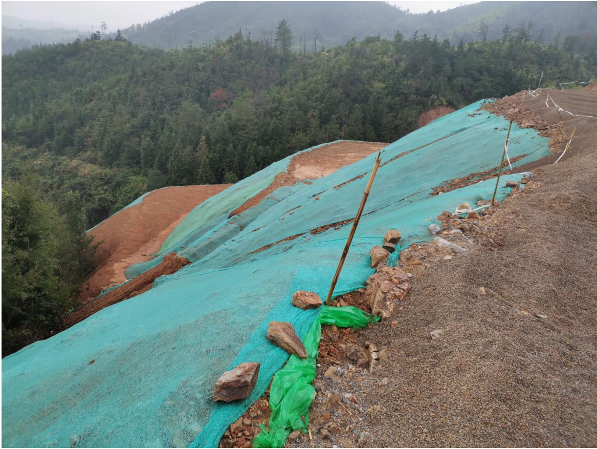
弃渣场苫布覆盖（2021年9月）
