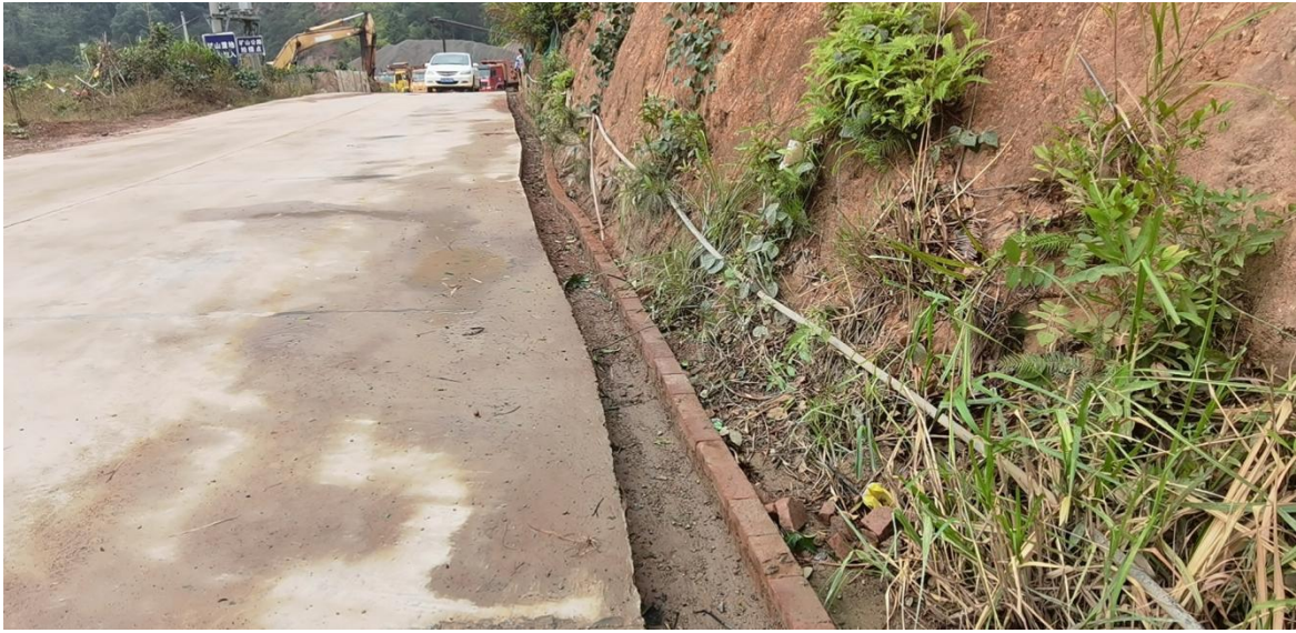
矿山道路区排水设施（2021年9月）
