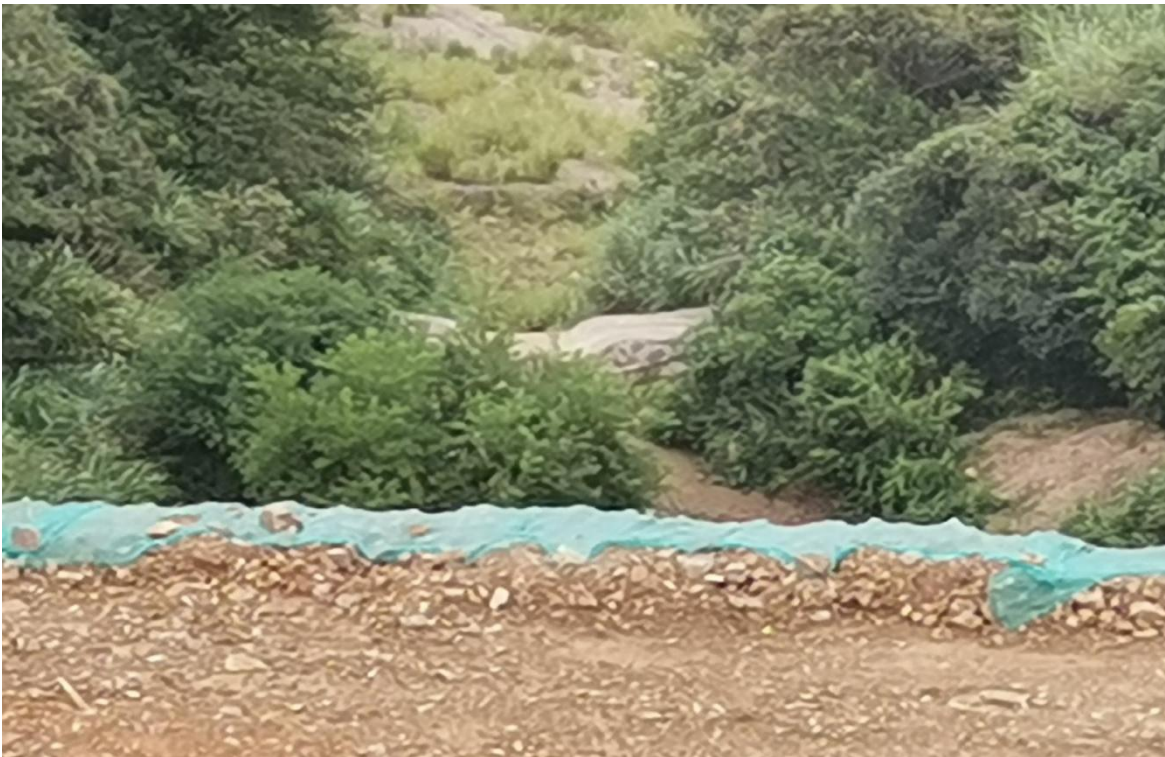
弃渣场挡土墙 (2021年9月)
