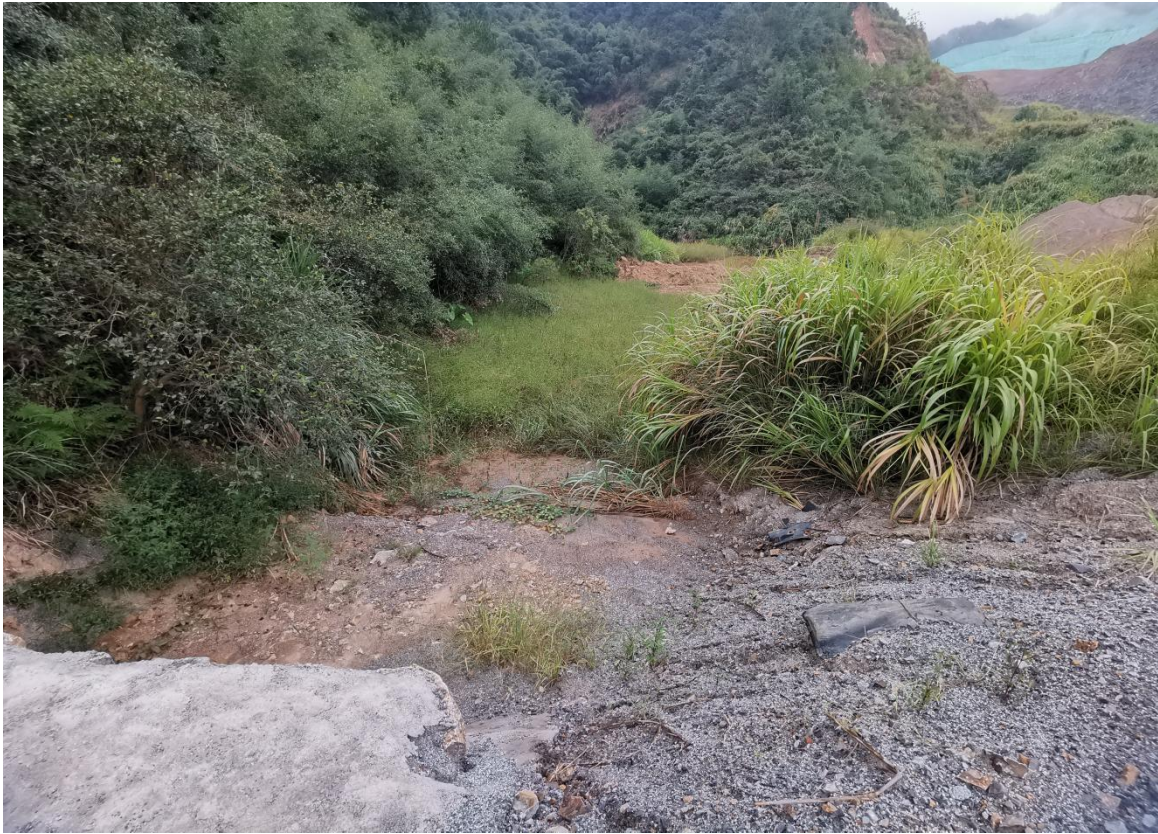
生产生活区沉砂池（2021年9月）
