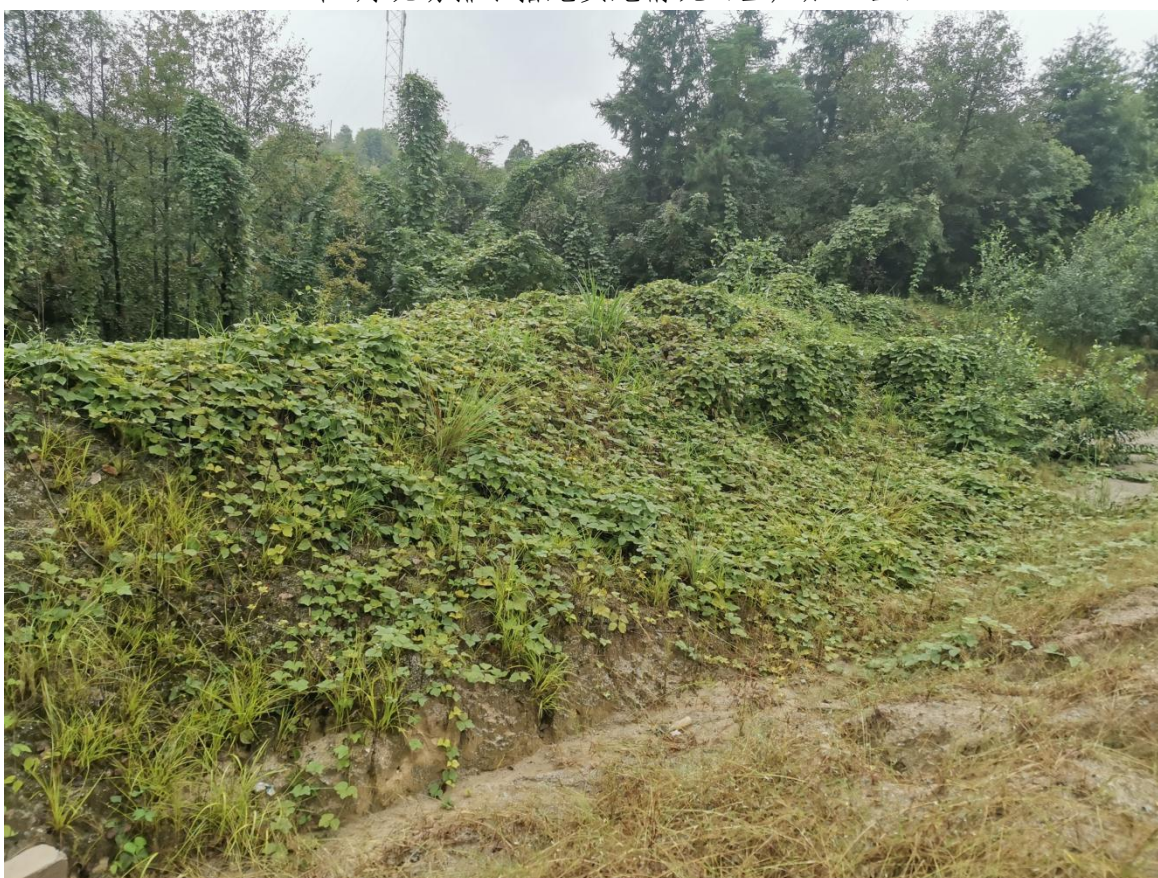
2021年8月现场植物措施实施情况（表土堆放区）
