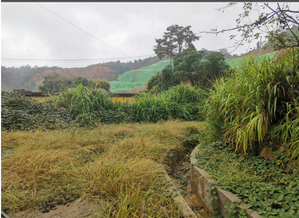
2021年8月现场排水措施实施情况（生产加工区）
