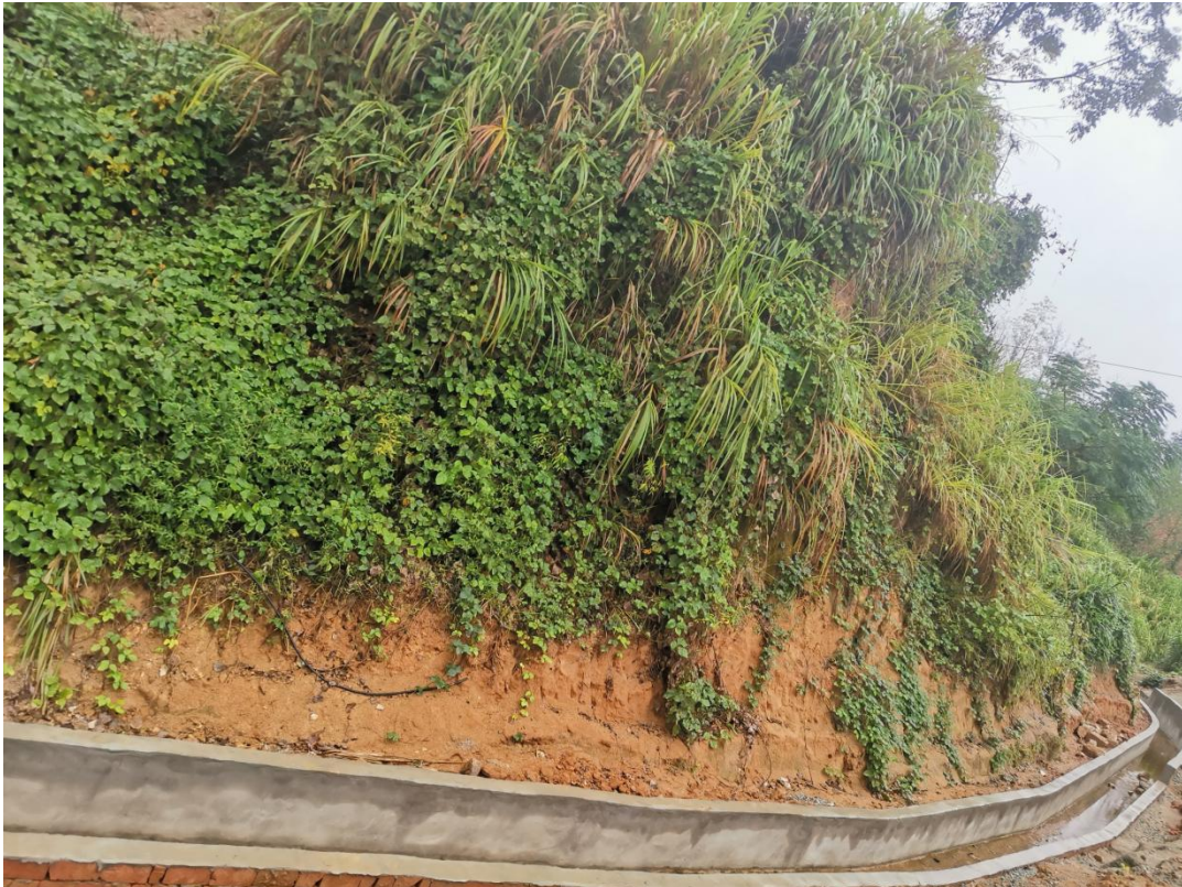
生产加工区工程措施（2021年9月）
