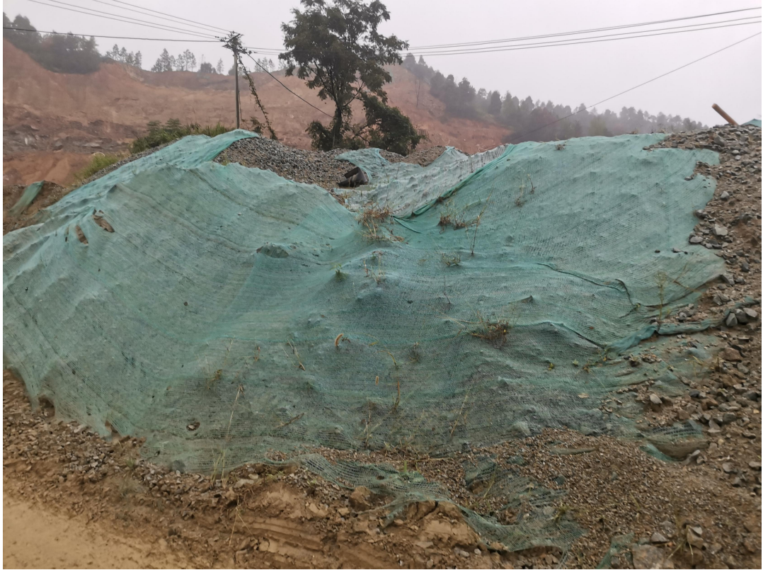
生产加工区临时措施（2021年8月）
